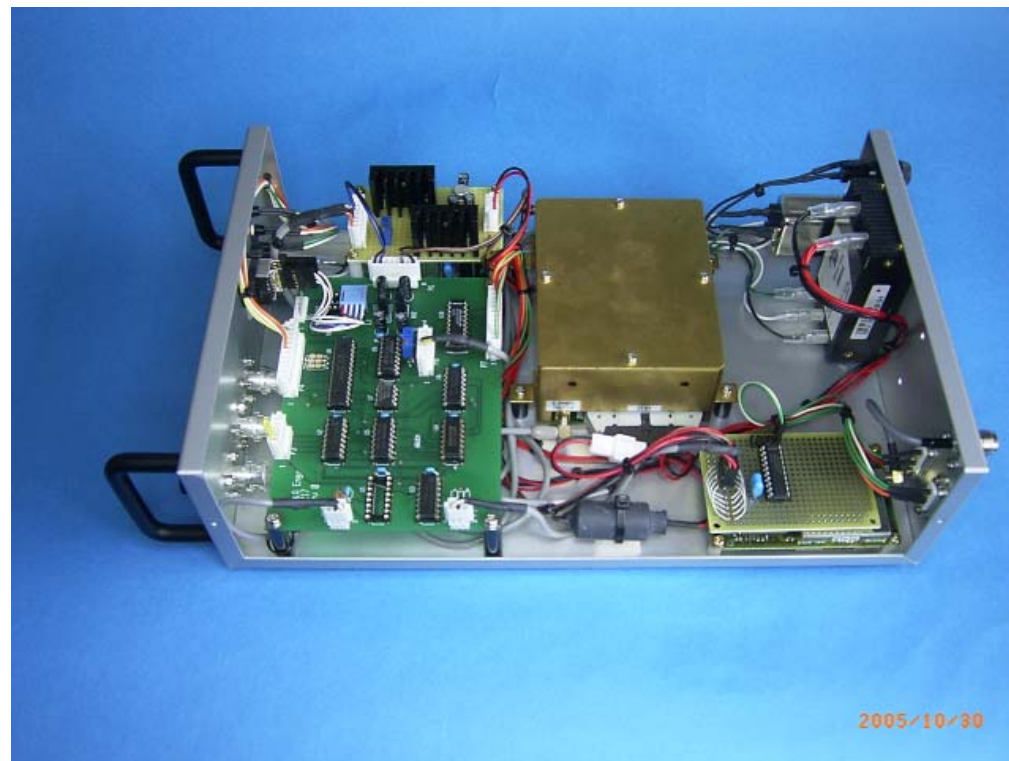
写真-1 : GPS 同期オシレータの内部
